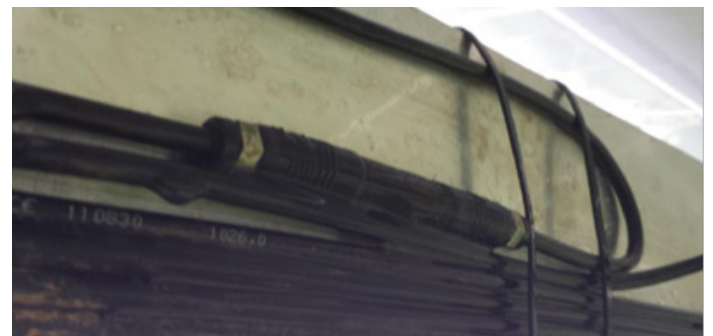
그림 10: 커넥터를 마운팅 구조물에 꽂 조이면 커넥터와 레일 사이에 습기가 축적되어 연결부가 손상될 수 있습니다.
